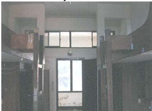
整修前翠亨宿舍C/ D棟
