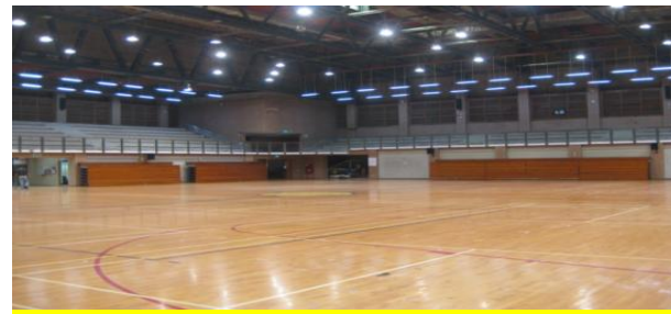
體育館3F天花板整修後
